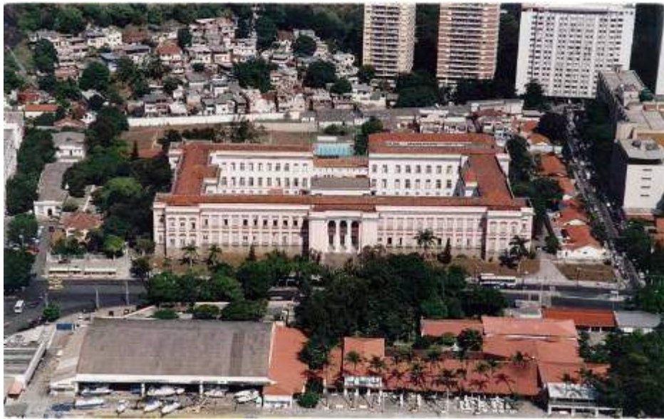
Figura 1 - Vista aérea do prédio do IBC. Acervo fotográfico do MIBC. Rio de Janeiro: IBC, 2000. (Foto Paula Kossatz)
